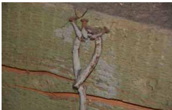
**Abb. 7** Befestigung mit Nägeln
